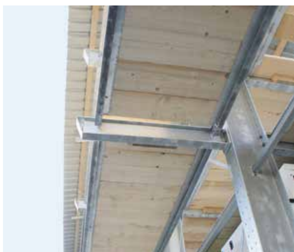
1 Support de pont sur poutres- consoles
